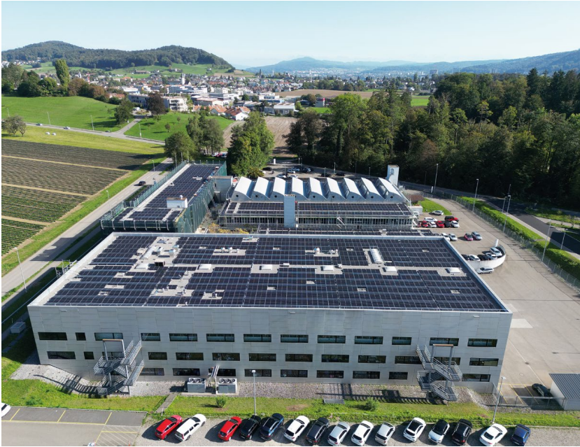
Huba-PV-Anlage-AEW_V01.jpg: Su uno spazio di circa 3456 metri quadrati, sui tetti della Huba Control AG di Würenlos, è stato costruito un impianto fotovoltaico all'avanguardia.
