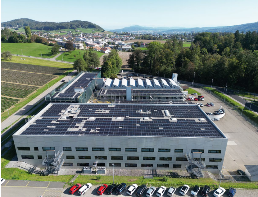
Huba-PV-Anlage-AEW_V01.jpg, © AEW Energie AG: Auf den Dächern der Huba Control AG in Würenlos entsteht auf ca. 3456 Quadratmetern eine hochmoderne PV-Anlage.
