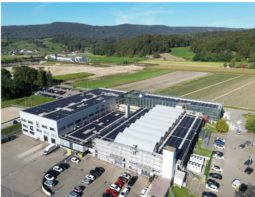
Huba-PV-Anlage-AEW_V02.jpg, © AEW Energie AG
